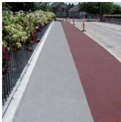
Degadur Bridge er anvendt på fortov og cykelsti på broen ved Algade og Næstvedvej i Vordingborg
