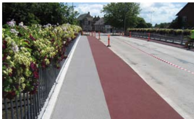
Degadur Bridge er anvendt på fortove og cykelsti på broen ved Algade og Næstvedvej i Vordingborg
