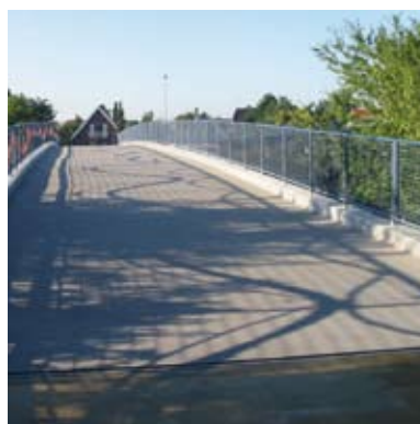
Degadur Bridge er anvendt på gangbro over motorvejring ved Hvidovre
