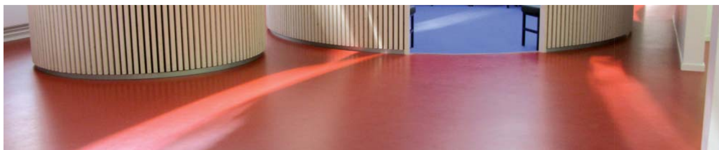
Idet Mastertop 1325 pålægges i flydende form er det nemt for gulvlæggeren at udlægge gulvet omkring kreative geometriske former som her ved "rundkredsrummene".
