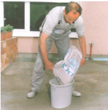
2. PCI Seccoral 2K pulver røres til en klumpfri masse.
