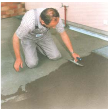
4. Når 1. lag PCI Seccoral 2K er klæbefri, men ikke gennemhærdet udlægges 2. og evt. 3. lag. Ved lagtykkelser op til 5 mm benyttes spatel.
