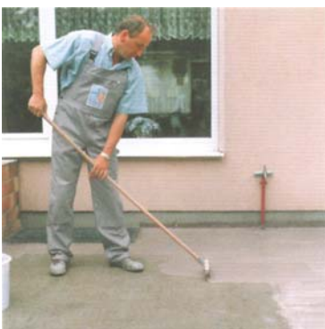
3. På forvandet undergrund udlægges 1. lag PCI Seccoral 2K (væske fortyndet med 10% vand)
